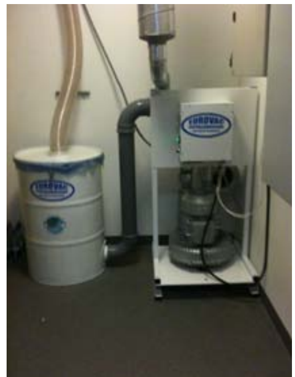
Bilden visar exempel på 5,5 kw pumpenhet med frekvenstyrning samt Barrel filterenhet speciellt lämpad för textildamm / ludd
